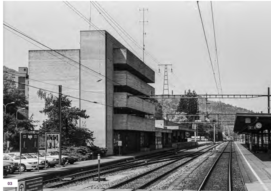
03 Maximale Abschottung mit 2 Meter hohen Betonbrüstungen. Die Laubengänge am Bahnhof Killwangen (1970) schirmen sich vom Lärm der Geleise ab. FOTO: ETH-Bibliothek Zürich, Bildarchiv / SIK_02-04-4015
