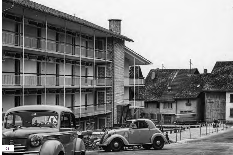
01 Frühes Beispiel eines «modernen» Laubenganghauses von 1956 an der Gsteigstrasse in Zürich. FOTO: Gsteigstrasse | Baugeschichtliches Archiv
