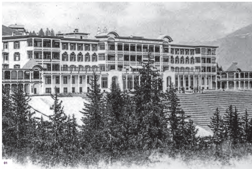
01 Lauben prägen die Architektur des Sanatoriums Schatzalp in Davos (1898-1900). Ihr Zweck ist nicht das Erschliessen von Räumen, sondern hier erholten sich Tuberkulosekranke an der Bergluft. FOTO: Urheber:in unbekannt
