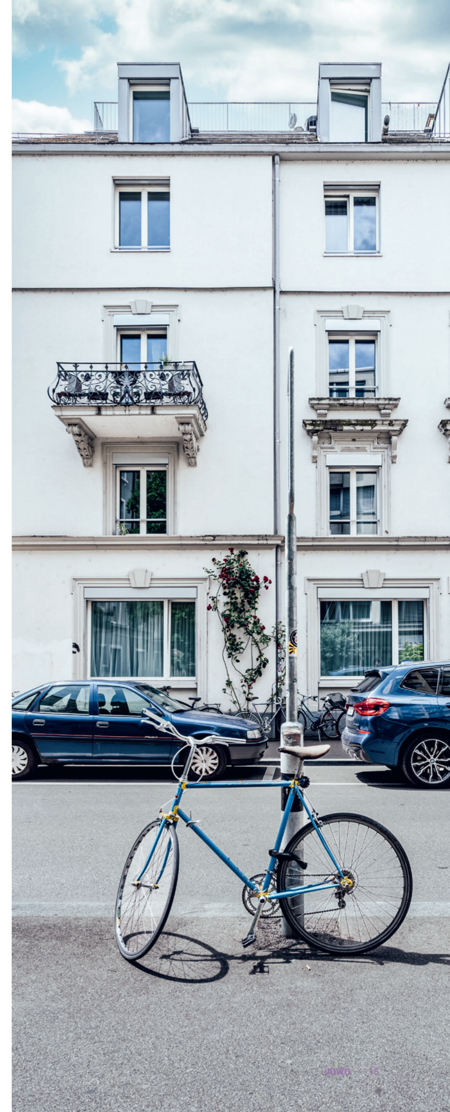
JUWO-Liegenschaft Müllerstrasse, Zürich FOTO: Pirmin Henseler
